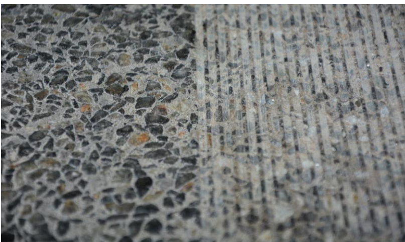
ABB 1. Waschbeton (links) und Grindingoberfläche rechts)
