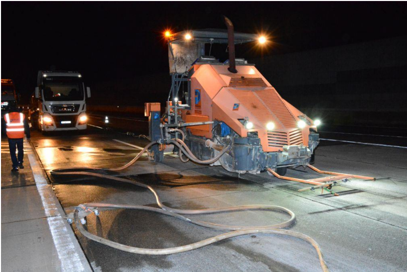
ABB 2. Herstellung einer Grinding-Versuchsstrecke
